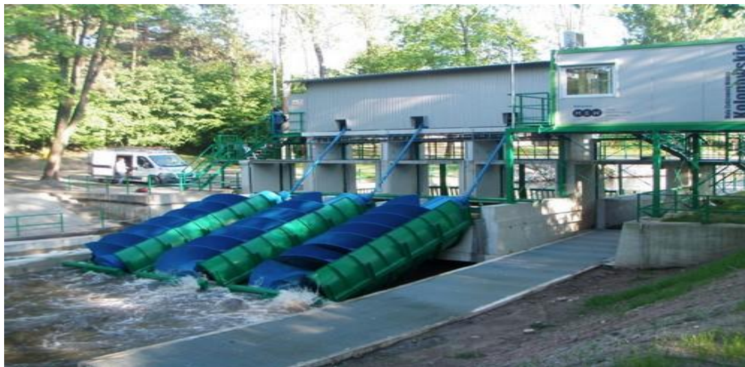
Рис.4. Винтовые турбина Архимеда на село Агалы Агдамского района
