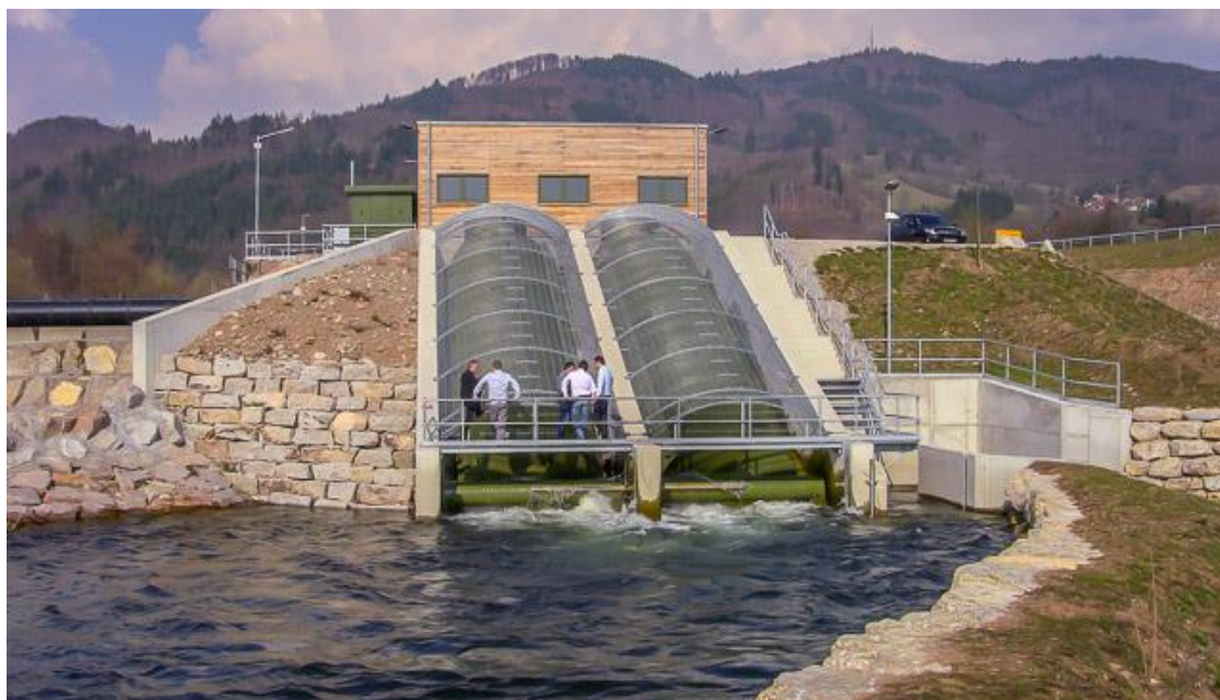
Рис.3. Винтовые турбина Архимеда на село Агалы Агдамского района
