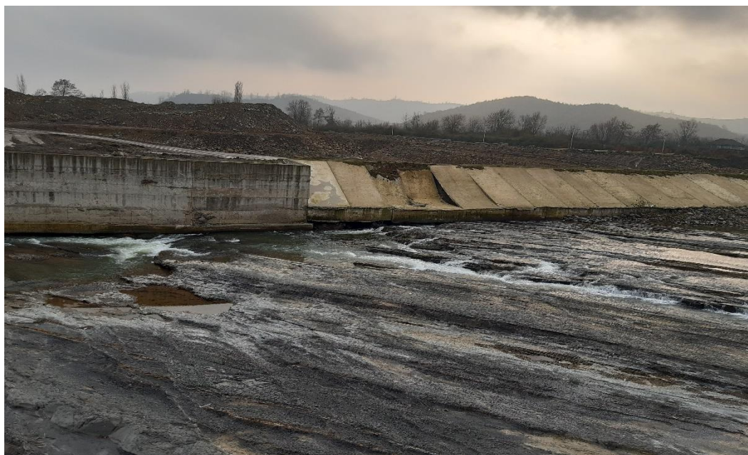
Рисунок.1 Вид берегоукрепительные сооружения
