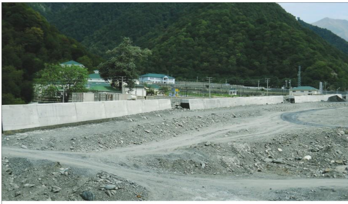
Рисунок.3 Вид берегоукрепительные сооружения
