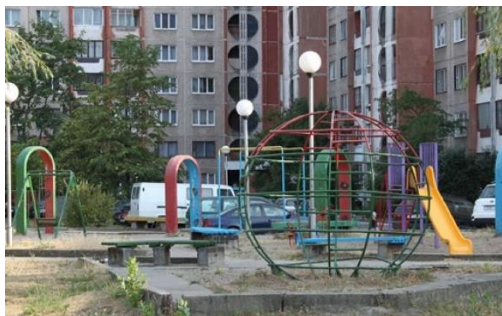
Детская площадка (опасные для детей металлические конструкции, яркие цвета, которые необходимо обновлять)
