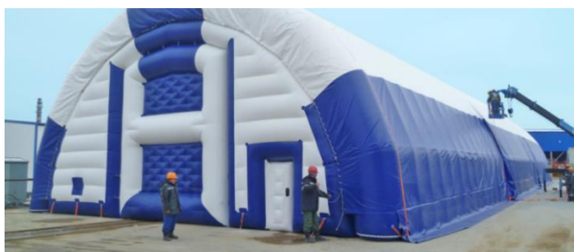
Рис. 2. Воздушно-несомое пневмоарочное сооружение
