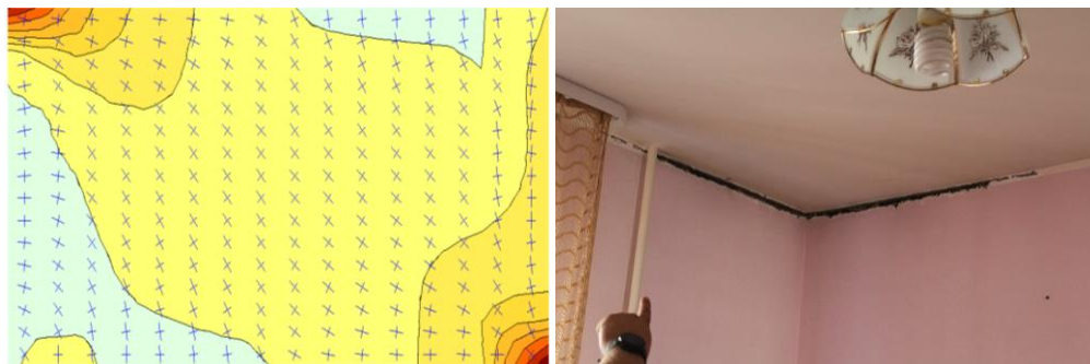
Рис. 2. Изополя растягивающих напряжений в рядовой ячейке глухой ограждающей стены и примеры трещин, образовавшихся между плитами перекрытия и вертикальным стеновым заполнением. Максимальное растягивающее напряжение 38 \text{ кН/м}^2
